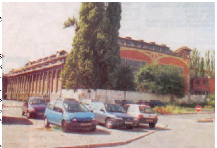
Une partie des bâtiments aujourd'hui
