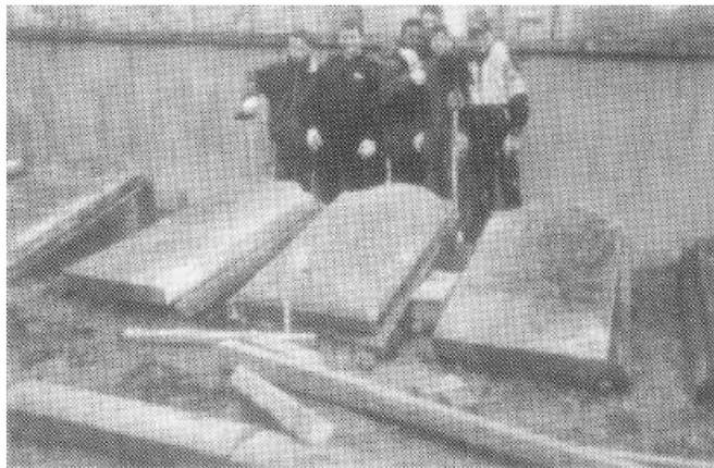
3. Remise en place de la dalle par ripage face à son emplacement, puis poussage à la base par un cric et roulage en tête sur un manche à balai en bois dur. Ajustement à la main..
