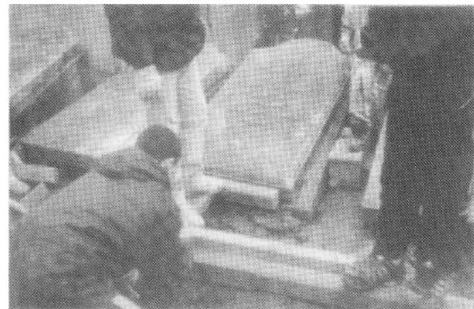
1. Démontage de la dalle, soulevée à l'aide de cordes et ripée sur le gazon
