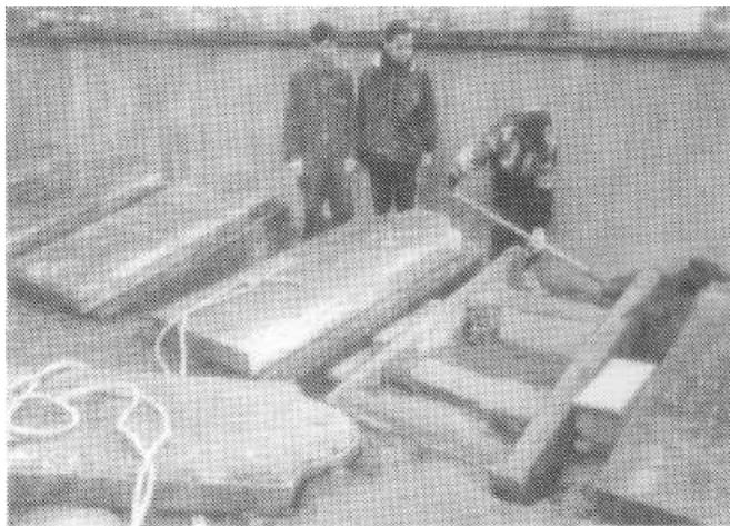
2. Démontage des cloisons latérales qui étaient affaissées, remise en place verticalement sur un mortier de béton, construction de 2 cloisons perpendiculaires en agglos de 20.
