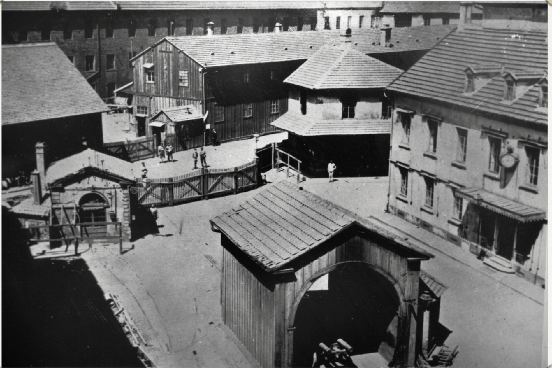
En 1875, l'usine est encore coupée en deux par la rue de Didenheim qui menait à la station provisoire de Mulhouse
