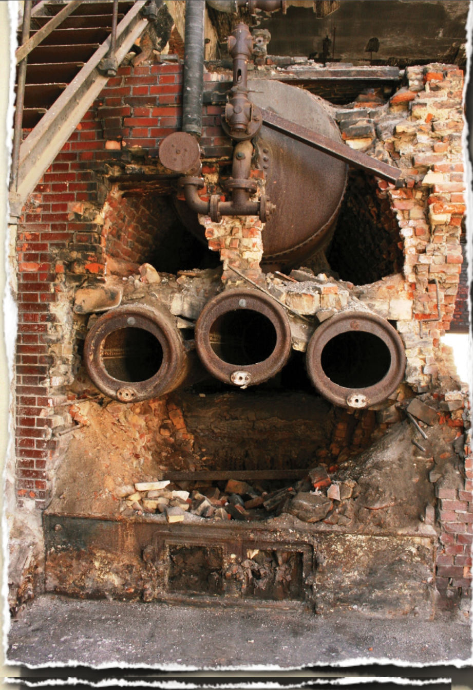
Des chaudières pour l'énergie et le processus d'ennoblissement textile (Wesserling)
